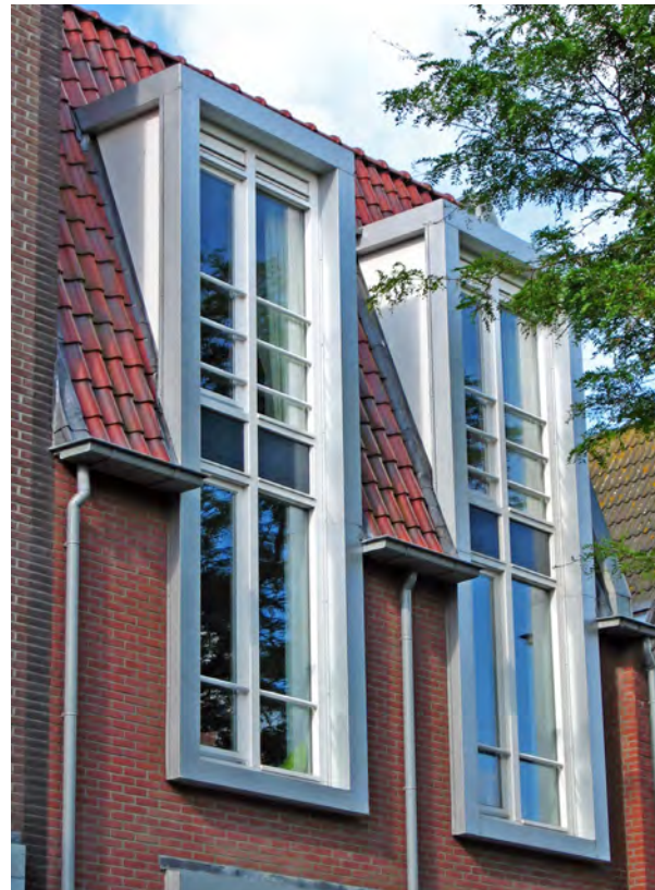
modern voorbeeld van een verticaal element in de gevel: elementen die over meerdere verdiepingen naar voren steken
