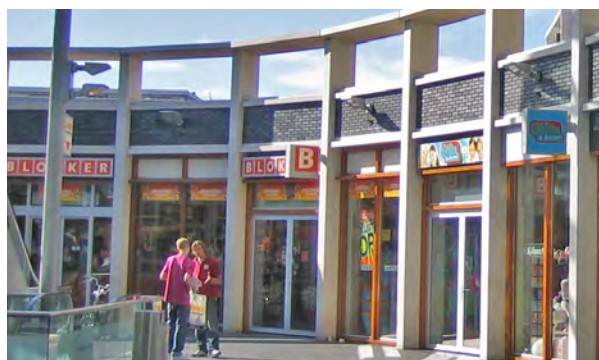
de uitbouw zelf is laag, maar elementen in de gevel worden hoger doorgetrokken om de uitbouw een passende schaal en massa te geven
